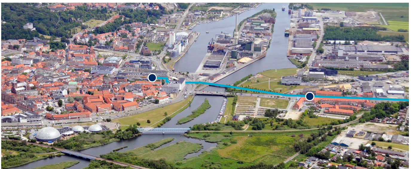
BRT fra Randers Busterminal til Randers Storcenter. Her er vist Randers Busterminal og stationen ved Grenåvej
